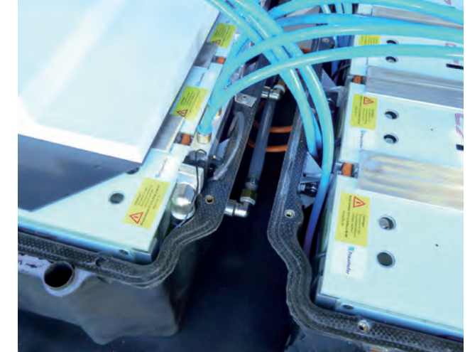
Flüssigkeitsbasiertes Kühlsystem für Lithium-Ionen-Batterien.
